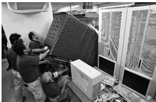
銀座仮社屋マシン室への、サーバー搬入作業(8月29日早朝)。
